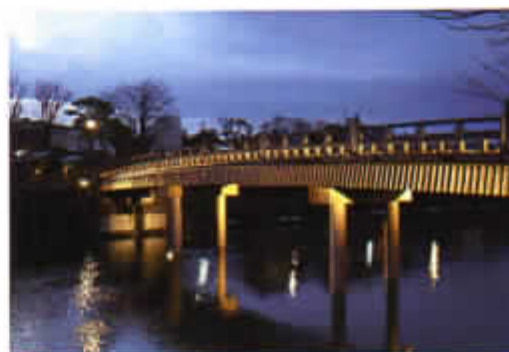
【④ 中の橋；平成29年度完成】
